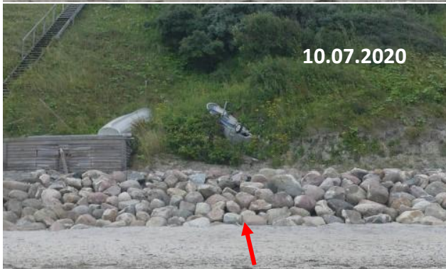
Skræntfodssikringen på den renoverede strækning bag høfde 3 i 2019, 2020 og 2021. Strandplanet hævet og sænket.
