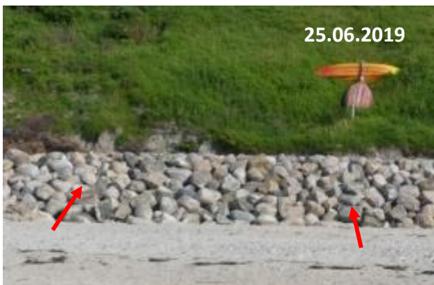
Skræntfodssikringen på den renoverede strækning bag høfde 3 i 2019, 2020 og 2021. Strandplanet hævet og sænket.
