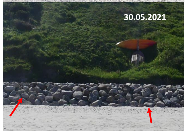
Skræntfodssikringen på den renoverede strækning mellem høfde 1 og 2 i 2019, 2020 og 2021. Strandplanet hævet.
