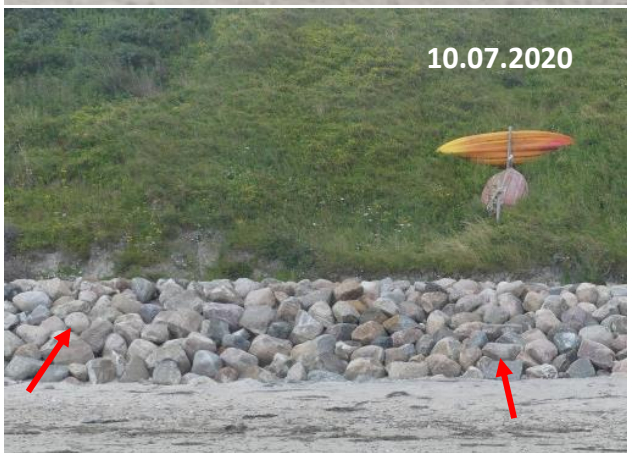
Skræntfodssikringen på den renoverede strækning mellem høfde 1 og 2 i 2019, 2020 og 2021. Strandplanet hævet.
