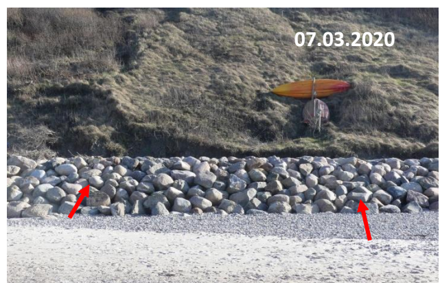
Skræntfodssikringen på den renoverede strækning bag høfde 3 i 2019, 2020 og 2021. Strandplanet hævet og sænket.
