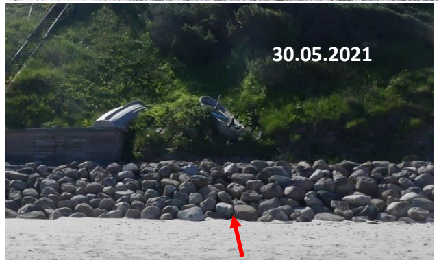
Skræntfodssikringen på den renoverede strækning bag høfde 3 i 2019, 2020 og 2021. Strandplanet hævet og sænket.
