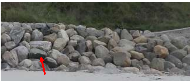
Skræntfodssikringen på den renoverede strækning mellem høfde 1 og 2 i 2020, 2021 og 2022. Strandplanet hævet.
