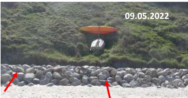
Skræntfodssikringen på den renoverede strækning mellem høfde 1 og 2 i 2020, 2021 og 2022. Strandplanet hævet.
