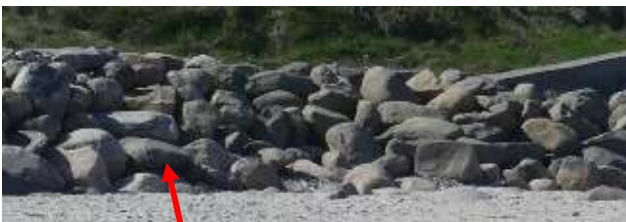
Skræntfodssikringen på den renoverede strækning mod nabo mod vest i 2020, 2021 og 2022. Strandplanet hævet.
