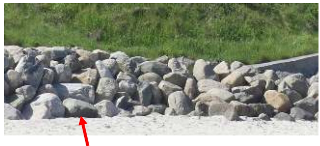
Skræntfodssikringen på den renoverede strækning mellem høfde 1 og 2 i 2020, 2021 og 2022. Strandplanet hævet.
