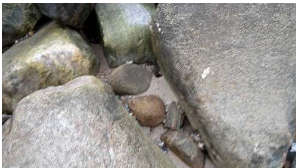
Figur 4-11 Blottet filterlag i bølgebryder 13.
