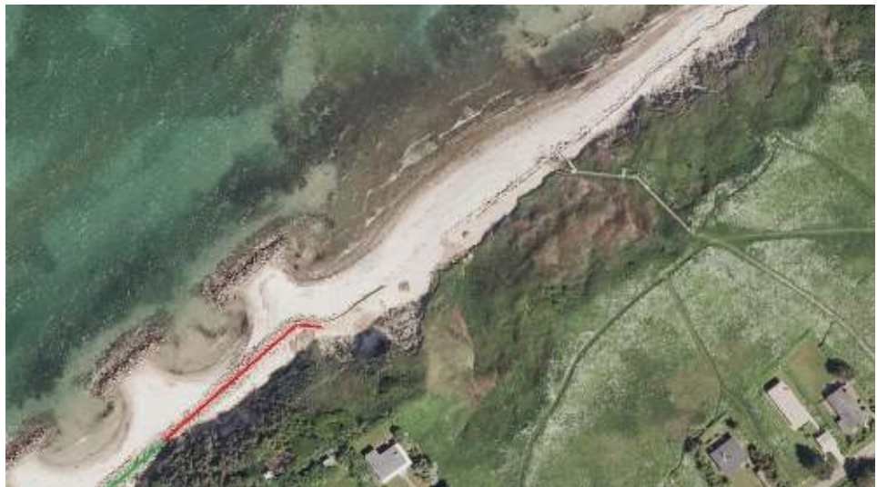
Figur 3-11 Bølgebryder 12 – 13, Den grønne linje indikerer at skræntfodssikringen har topkote i ca. +3,25, den røde linje indikere hvor niveauet er for lavt.
