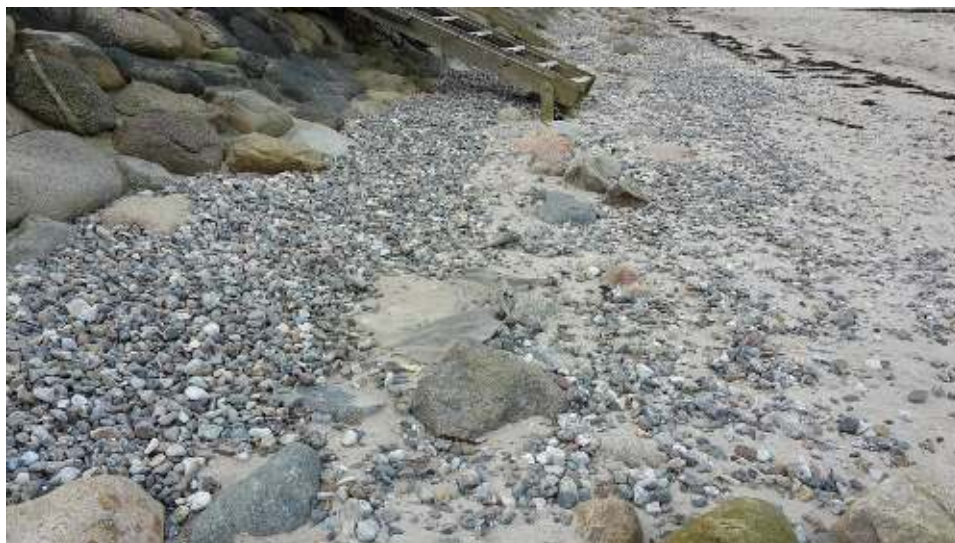
Figur 4-22 Erosionsbeskyttelse ved stenglacis.
