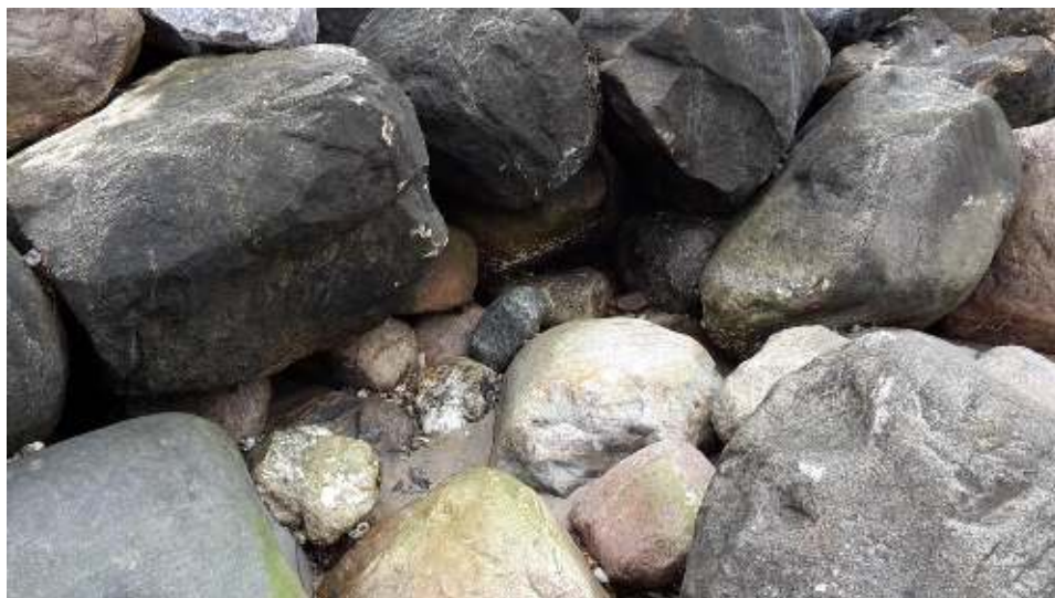
Figur 4-10 Blottet filterlag i bølgebryder 11.
