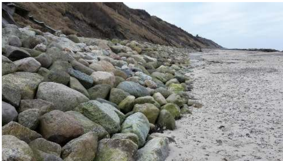
Figur 3-5 Skråningssikringsforløb set fra punkt bag bølgebryder og mod syd-vest.
