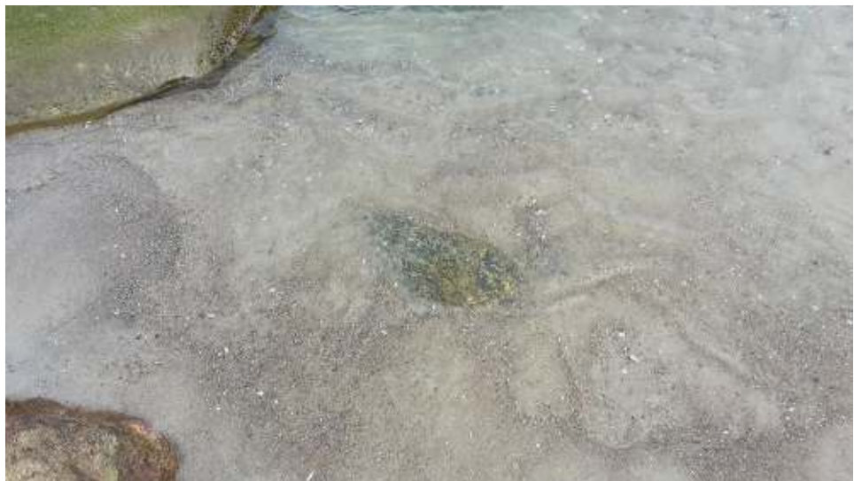
Figur 4-15 Eksempel på sandgået dæksten ved bølgebryder 5.
