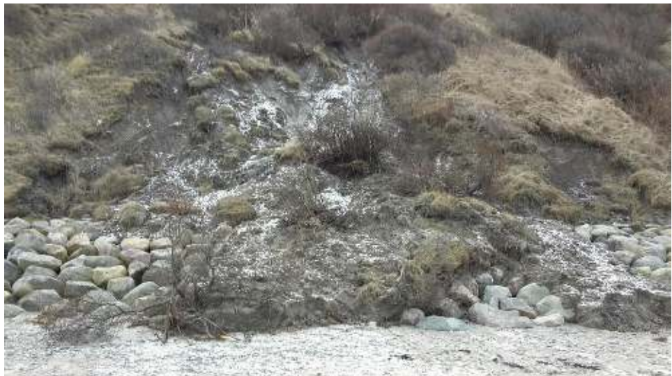
Figur 4-28 jordskred på strækning bag bølgebryder 7.
