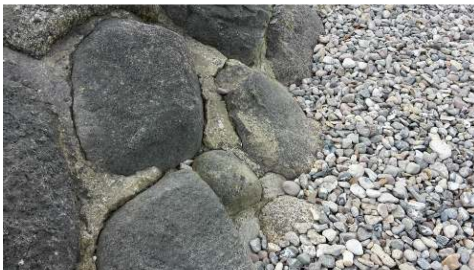
Figur 4-19 Eksempel på revnedannelse i beton.
