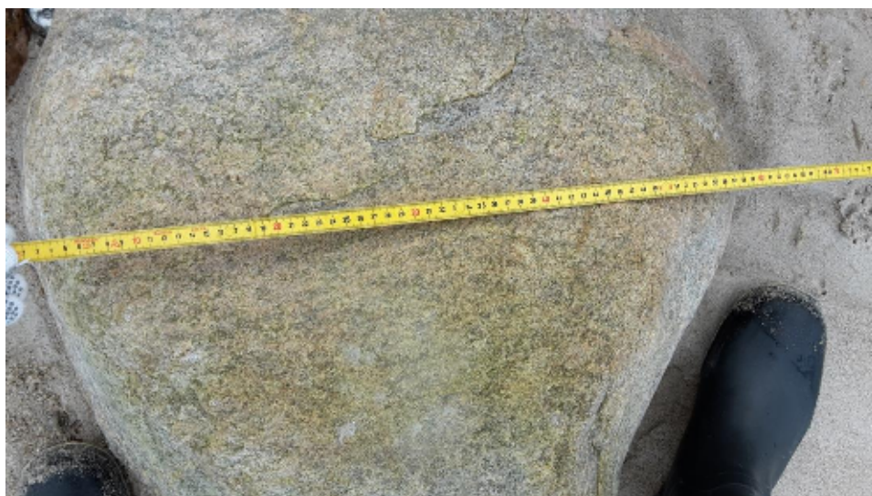
Figur 3-14 Udvalgt dæksten fra skråningsbeskyttelsen mellem bølgebryder 9 og 10.
