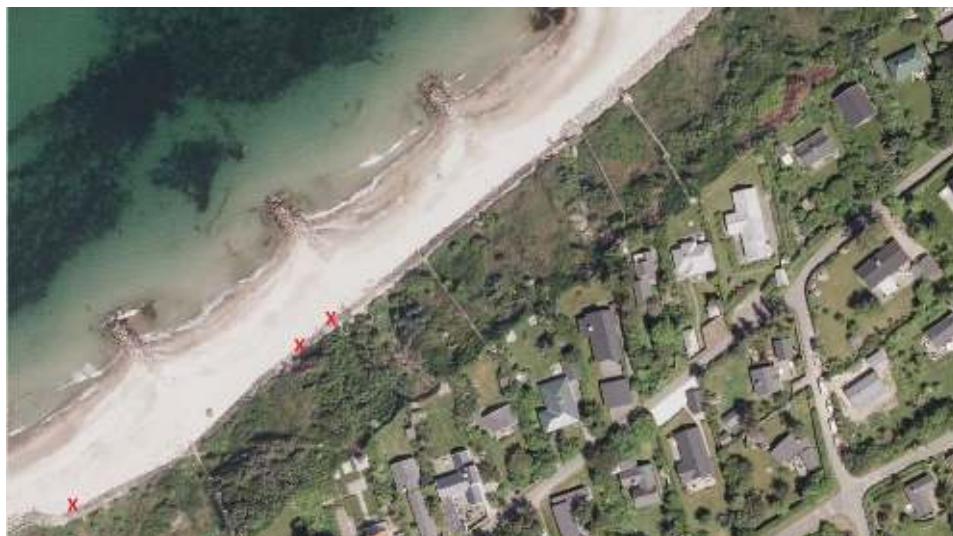
Figur 4-18 Højde 1 til 3, Rødt X markere observation af skader i betonstøbning.
