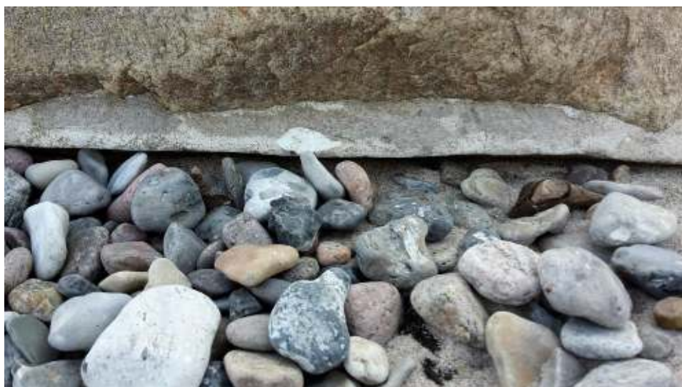
Figur 4-23 Begyndende underminering på strækning bag hofde 2 og 3.
