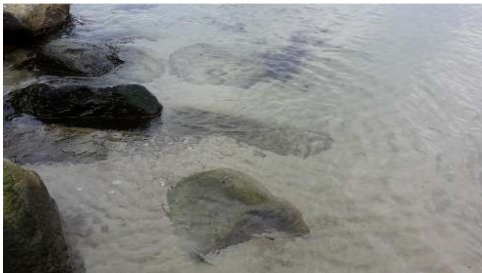
Figur 4-16 Eksempel på fejlplacerede dæksten ved bølgebryder 10.
