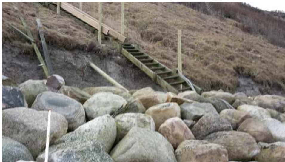
Figur 3-7 Trætrappe under konstruktion på strækning bag bølgebryder 9.
