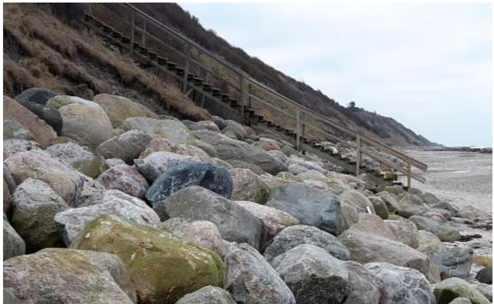
Figur 3-2 Trappe med afslutning i træ, på strækning bag bølgebryder 9 og 10
