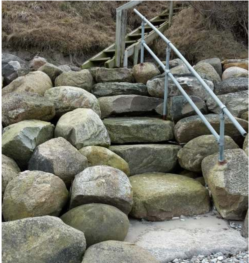
Figur 3-3 Trappe med afslutning i trædesten og stålækværk, på strækningen bag bølgebryder 7.
