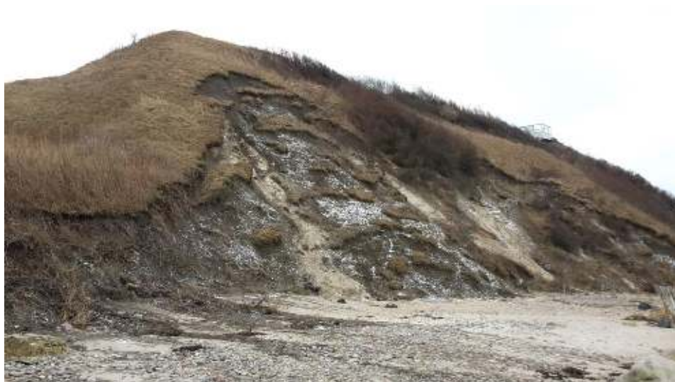
Figur 4-1 Jordskred for enden af beskyttet strækning efter bølgebryder 13.
