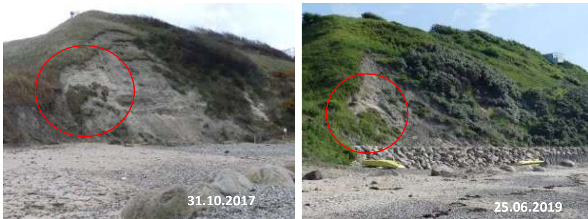
Klinten mod øst med den nye skræntfodsbeskyttelse til sikring mod skred under ekstremt højvande
