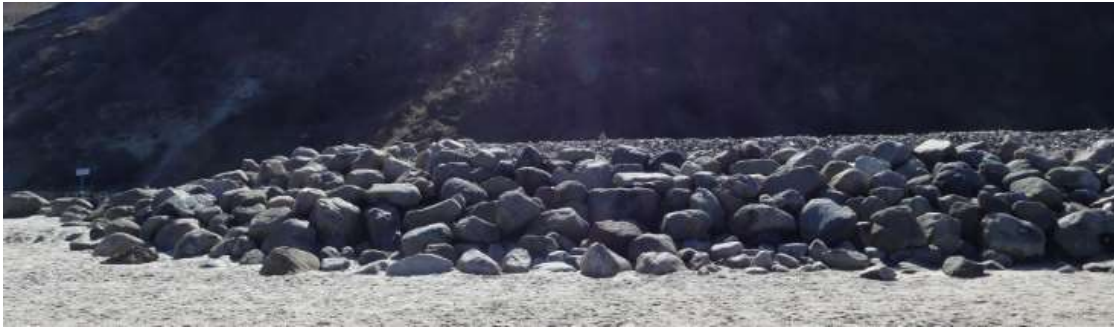
Østligste del af skræntfodsikringen. Det ses at skærvernes kote er højere end dækstenene på havsiden
