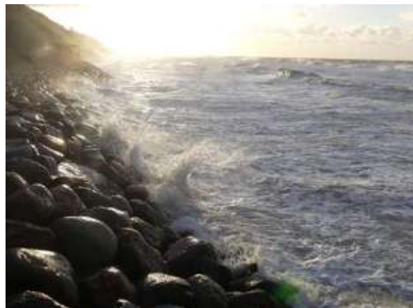
Bølgeopløb på skræntfodsikring øst og vest for Melby-trappen før stormens kulmination (vandstand +1m)
