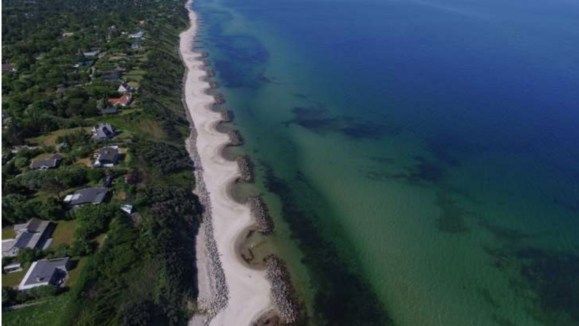
Anlægget set mod vest. Bølgebryder 13 i forgrunden
