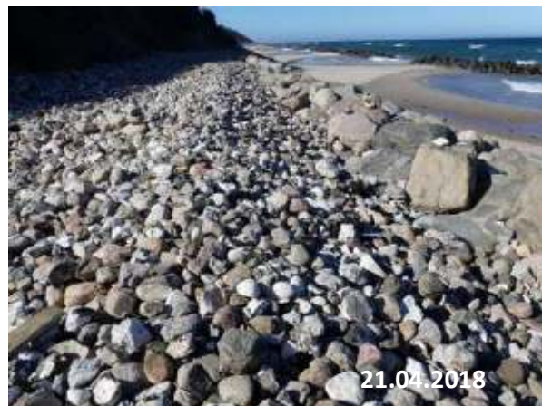
Opfyldningen i lunken på den østligste strækning af skræntfodsikringen og de store dæksten på yderskråningen er uændret efter vinteren 2017-18.
