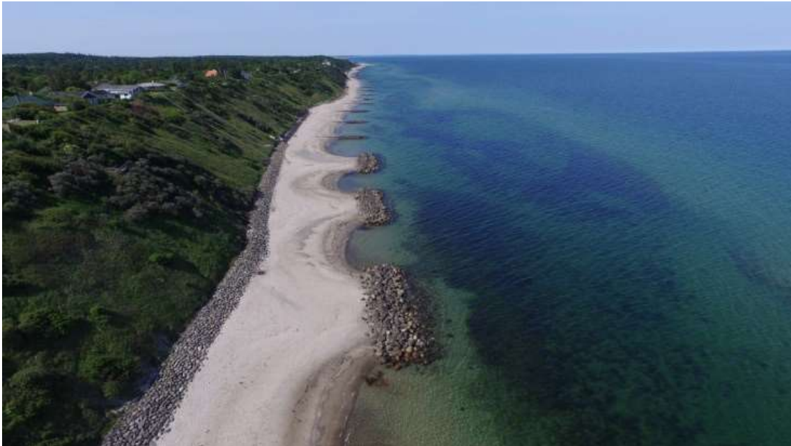
Anlægget set mod vest. Bølgebryder 6 i forgrunden.
