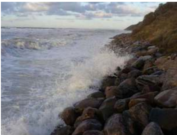
Bølgeopløb på skræntfodsikring øst og vest for Melby-trappen før stormens kulmination (vandstand +1m)
