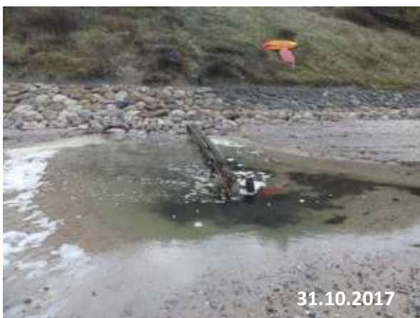
Erosion under INGOLF mellem høfde 1 og 2
