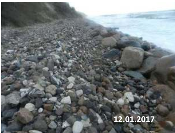
Opfyldningen i lunken på den østligste strækning af skræntfodsikringen og de store dæksten på yderskråningen er uændret efter vinteren 2017-18.
